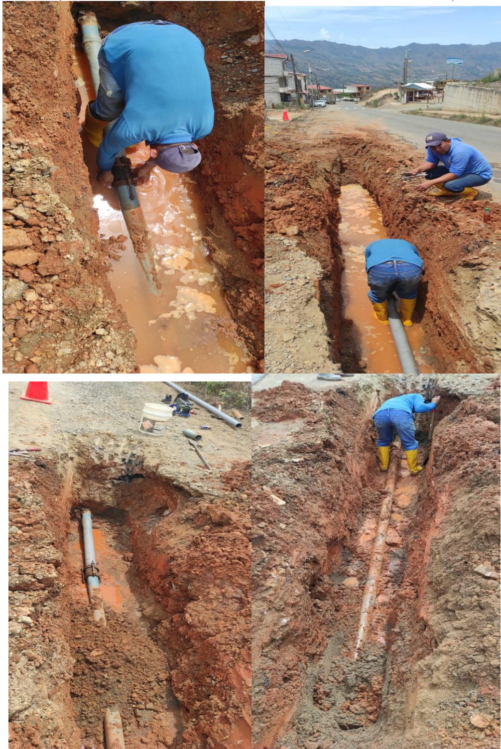
Reparación de la tubería de distribución 90mm en la Urb. Vizcaya
